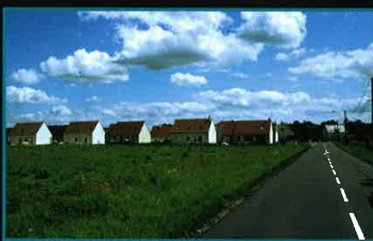
Exemple de lotissement sans aménagement paysager
